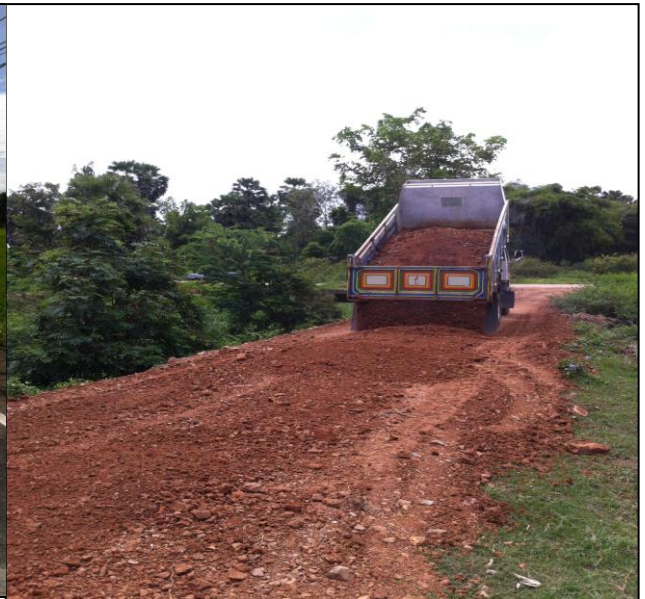
ปรับปรุงถนนลูกรังพร้อมบดอัดถนนเรียบลำห้วยโพธิ์กรู
